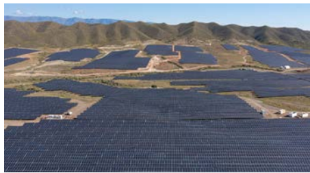
Photovoltaikpark La Cabrita - Almería, Spanien 122.000 PV-Module in Süd-Spanien In Betrieb seit 2021
