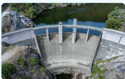
Kleinwasserkraftwerke „Sagres“, Portugal
